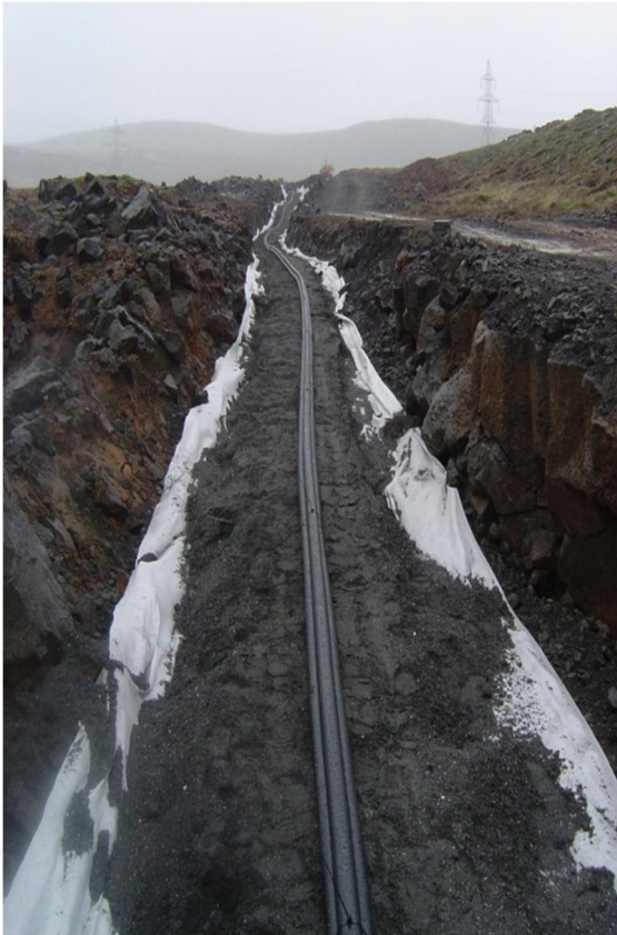
Mynd 2.3 Rask við lagningu háspennnts jarðstrengs (132 kV) í hrauni við Hamranes í Hafnarfirði árið 2007(t.v.) og lagningu Nesjavallalínu 2 (132 kV)árið 2009.
