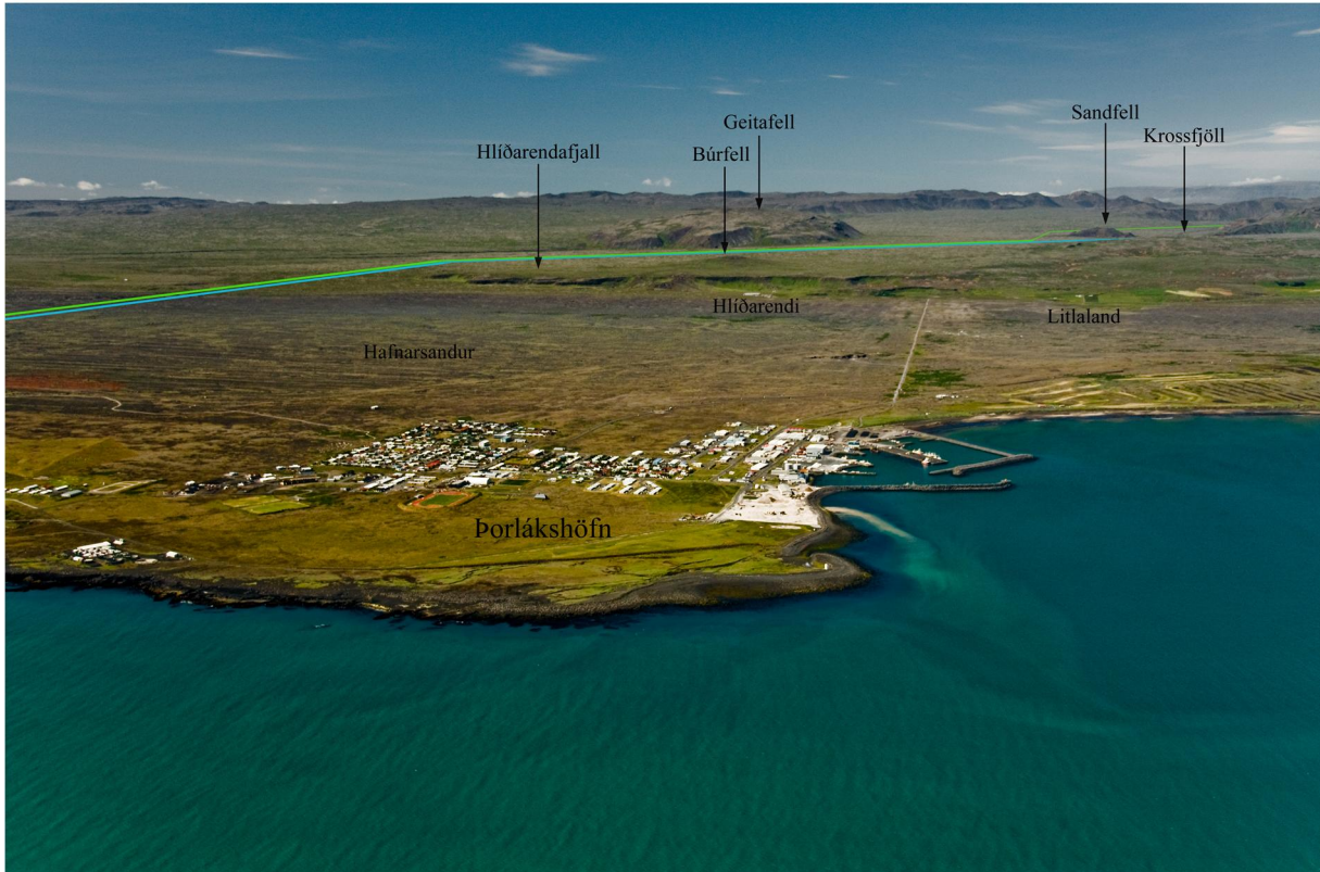
Mynd 3.12 Horft norður yfir Þorlákshöfn, Geitafellið fyrri miðri mynd. Línurnar eru ofan við Krossfjöll, Búrfell og Hlíðarendafjall. Þorlákshafnarlína 2, græn, Þorlákshafnarlína 3, blá.
