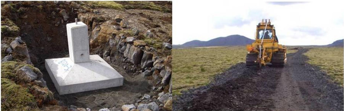
Mynd 2.10 Til vinstri má sjá forsteypa undirstöðu M-masturs og hægri sést hvernig jarðskaut er plægt í vegslóð.
