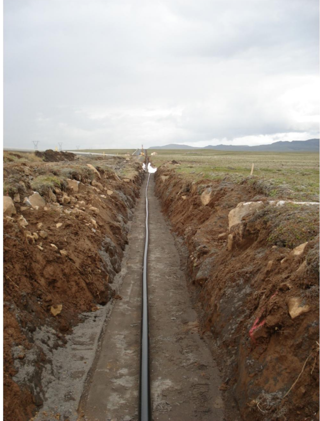
Mynd 2.3 Rask við lagningu háspennnts jarðstrengs (132 kV) í hrauni við Hamranes í Hafnarfirði árið 2007(t.v.) og lagningu Nesjavallalínu 2 (132 kV)árið 2009.
