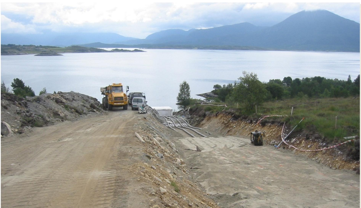
Mynd 2.4 Rask við lagningu háspennnts jarðstrengs (400 kV).
