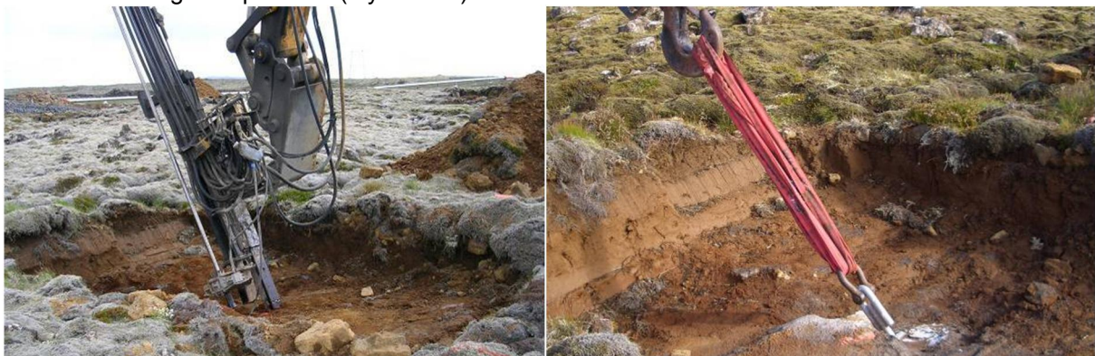
Mynd 2.11 Til vinstri sér hvar borað er fyrir bergbolta og myndin til hægri sýnir bergboltaprófun.
